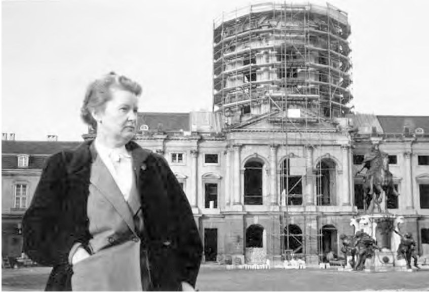
Abb. 4 Margarete Kühn vor dem eingestützten Mittelbau des Schlosses, Aufnahme 1953
