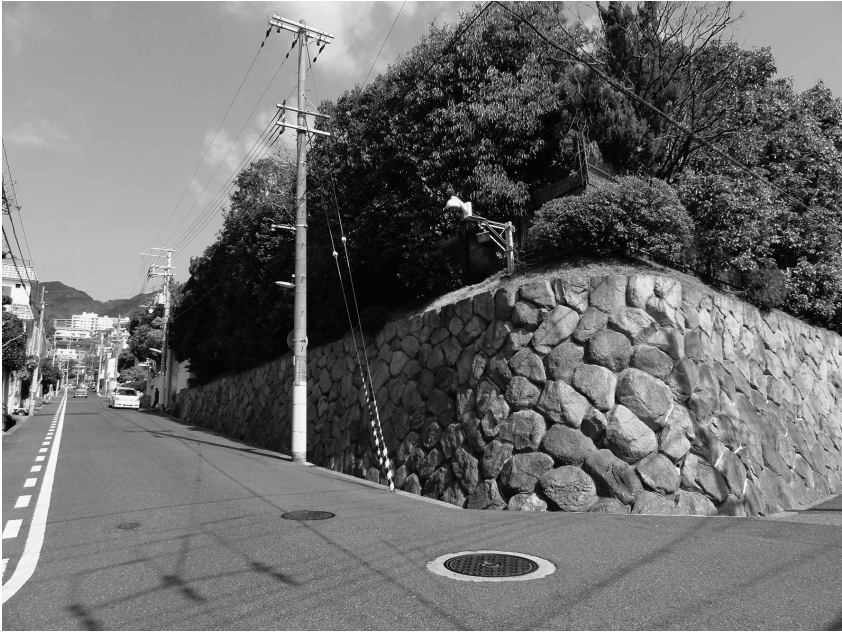
Abb. 1 Die „Festung“ der Yamaguchi-gumi in Kobe/Nada-ku. Hauptquartier Richtung Berg gesehen: Es erstreckt sich bis zum weißen Minibus (er steht am Vordereingang). Foto: W. H.
