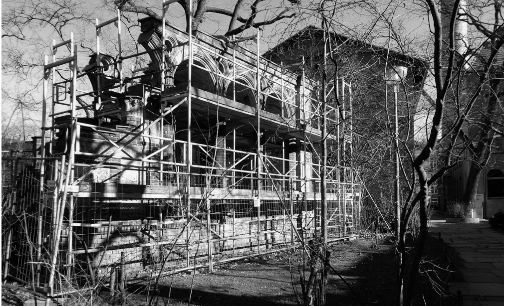
Abb. 8 Die eingerüsteten Arkaden, 2019
