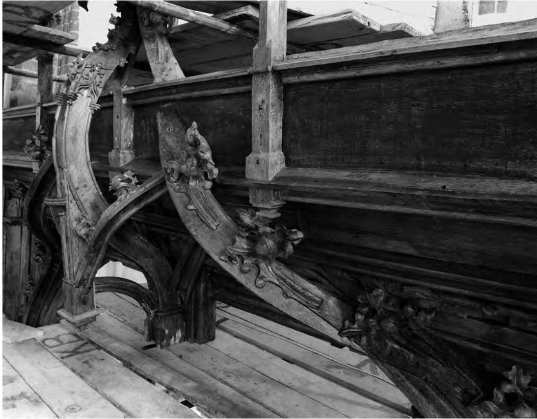
3. Lübeck, Dom. Triumphkreuzanlage, Unterbau (Zustand während der Restaurierung 1975/76)
