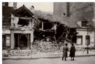
Das zerstörte Haus Schustehrusstraße 13, 1983 Foto: Wolfgang Reuss
